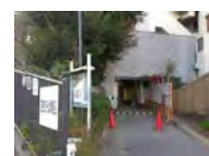
工事中の様子
