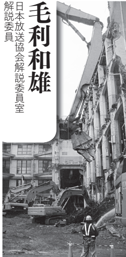
まるで爆撃にでも遭ったような、解体工事中の東京中央郵便局
